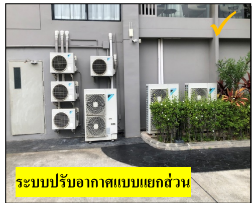
ระบบปรับอากาศแบบแยกส่วน
